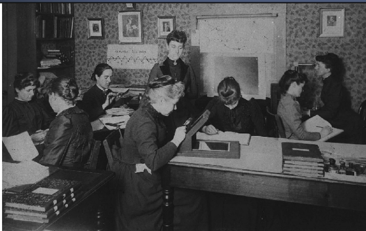
Figura 9. Análise de espectro. Note que uma das analistas usa uma lupa para ver estrelas de brilho muito fraco na chapa fotográfica.
