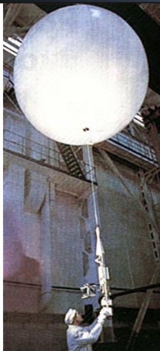
Figura 17. Testes do balão utilizado nas missões Vega 1 e Vega 2 realizado nas instalações da Corporação Lavochkin.
