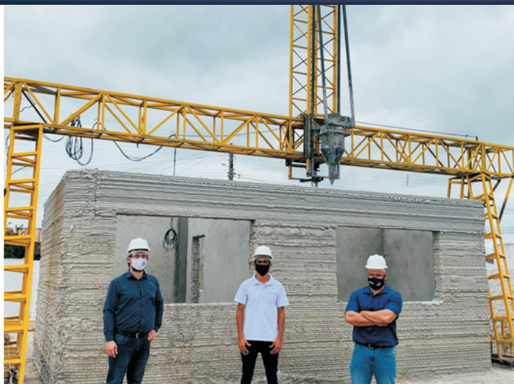
Imagem 3: Impressora 3D e uma casa sendo construída. Fonte: Inovação Tecnológica
