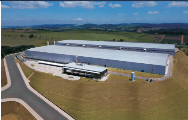
Um data center de IA.
